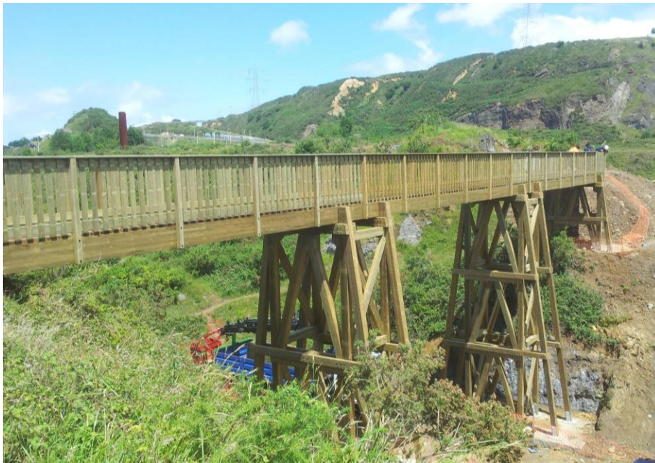
Fotos: Pasarela. Cortesía Protección y Tecnología de la Madera, S.L. Protec, www.protecmadera.com
