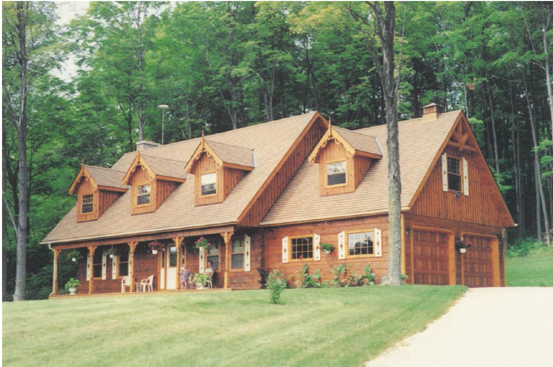
Foto: vivienda unifamiliar de madera maciza. Fuente Revista AITIM nº 162
