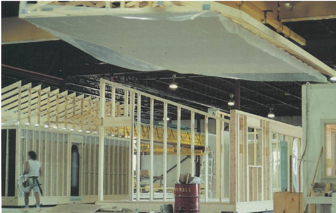
Foto: Fabricación casas prefabricadas de entramado ligero. Fuente Revista AITIM nº 162
