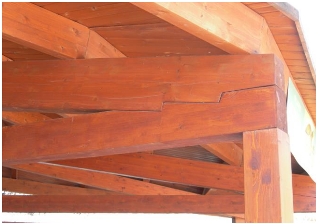
Foto: Embarbillado doble. Cortesía del Grupo de Investigación de Construcción con Madera de la UPM.
