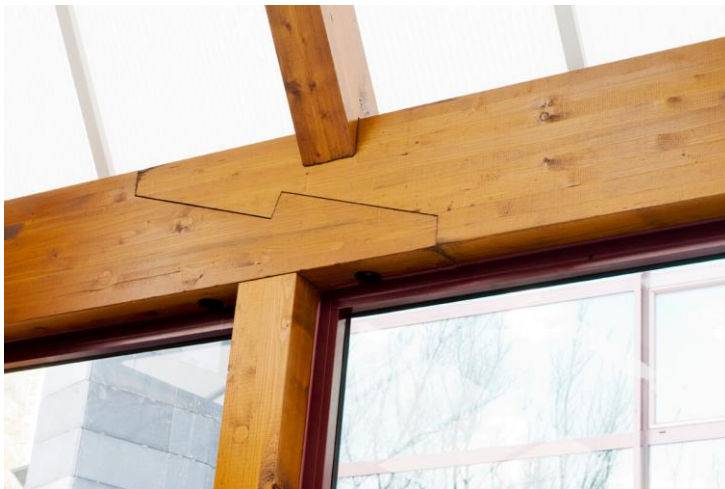
Foto: Rayo de Júpiter. Cortesía Jesfer, Mecanizados y Montajes en Madera S.L www.jesfer.com
